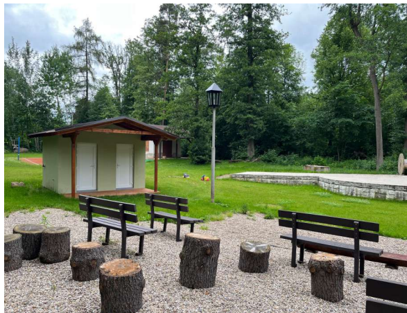
Rekonstrukce pokladny v areálu Šutráku
